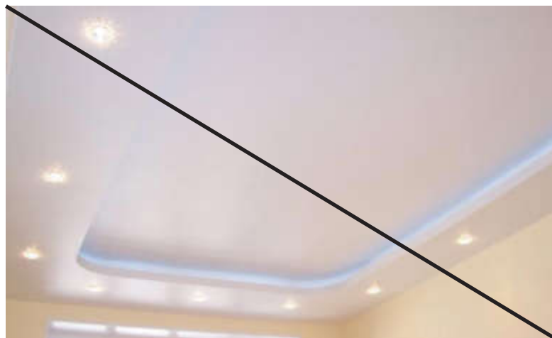
Плохо Многоуровневые гипсокартонные конструкции
